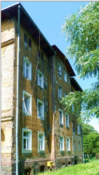
De familie Dierich woonde in het middelste appartement op de eerste verdieping aan de achterzijde.
